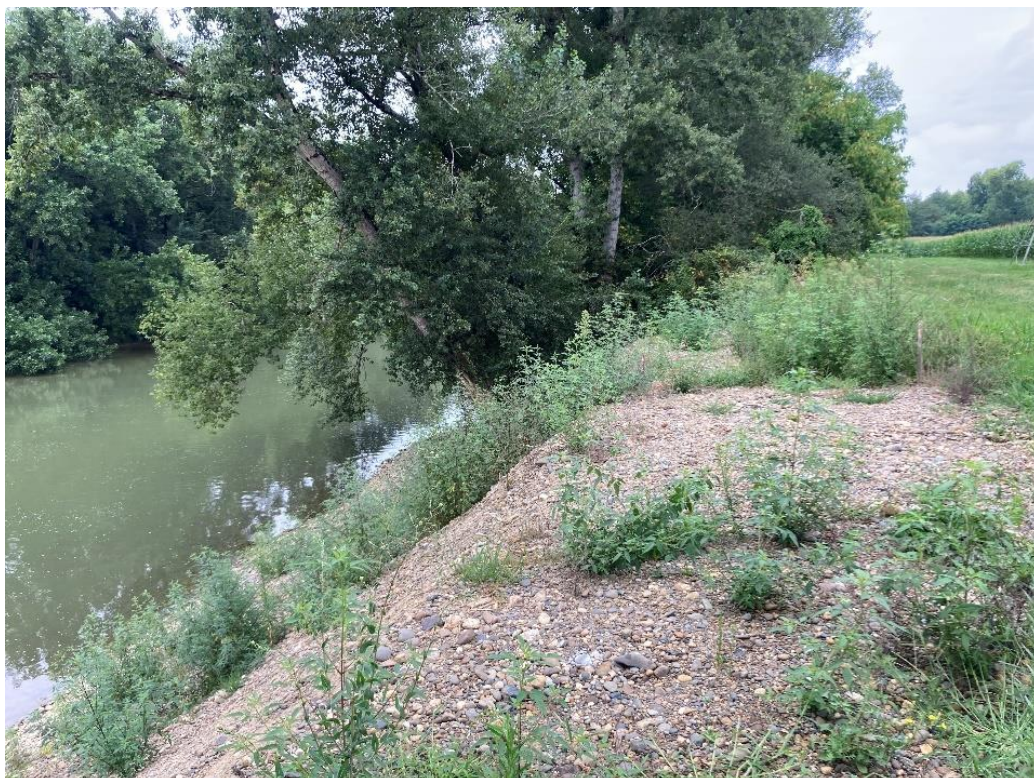
Figure 11. Photographie du merlon d'injection vu depuis l'amont en date du 13 août 2024.
